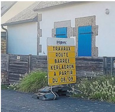
Des travaux de voirie se dérouleront sur l’axe de Kerlaeron jusqu’au 26 septembre.
